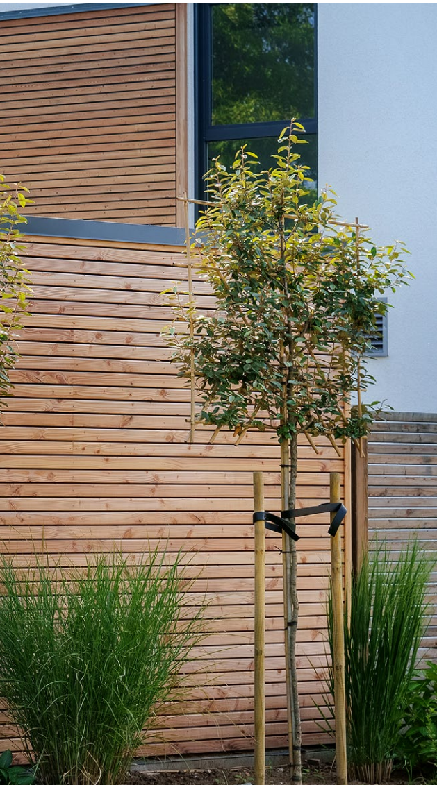
Rhombusprofil 27 x 68 mm, Douglasie unbehandelt, mit Außeneckleisten 42 mm
