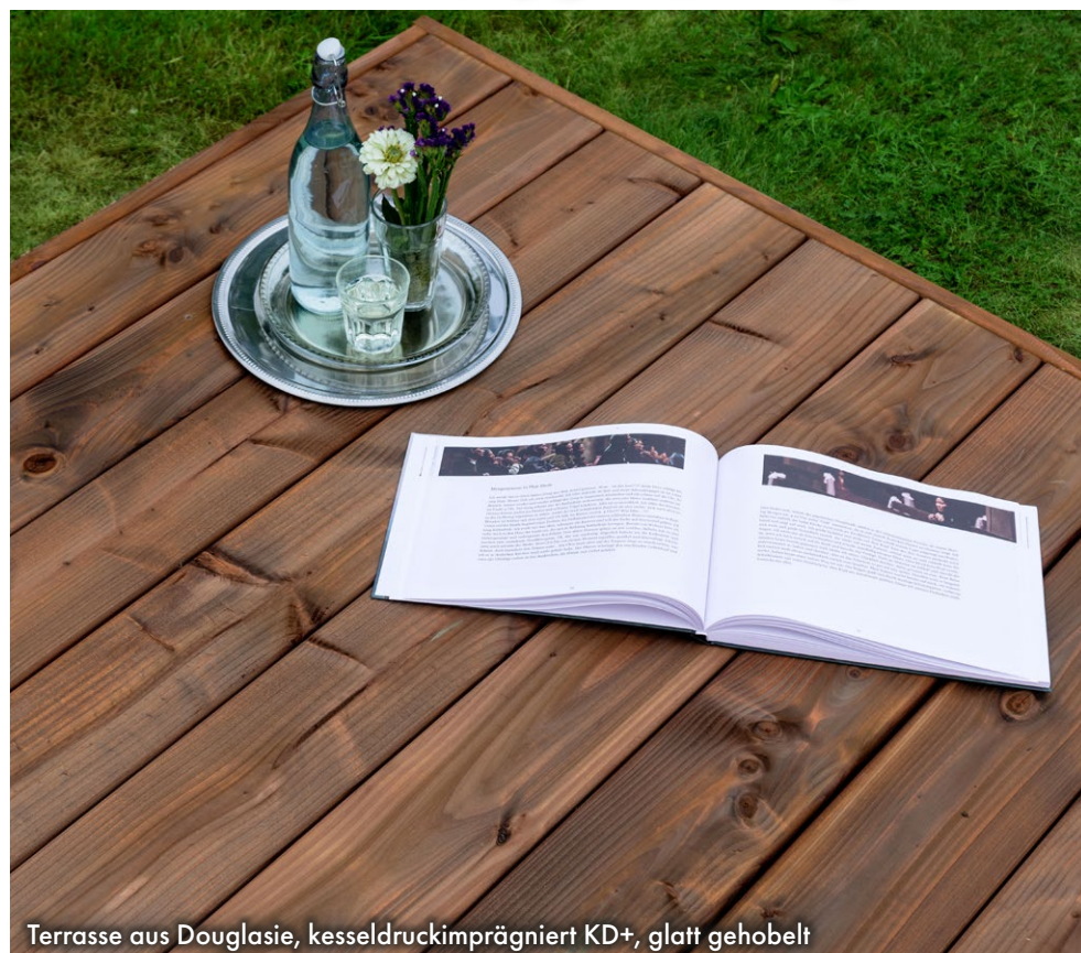
Terrasse aus Douglasie kesseldruckimprägniert KDG mit Premiumprofil
