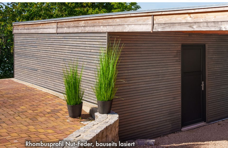
Rhombusprofil 27 x 68 mm, Douglasie unbehandelt, mit Außeneckleisten 42 mm
