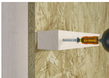
Befestigung einer Installationsebene
